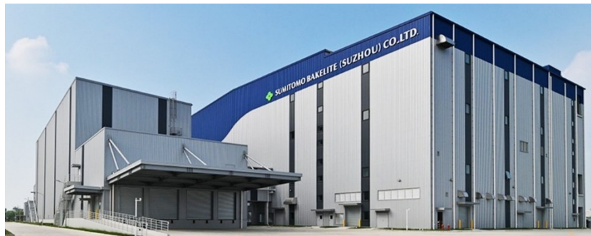
蘇州住友電木有限公司 半導体封止材の新工場(2024年竣工)
