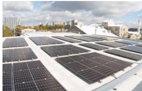
ソーラーアンカーを用いた防水シート
