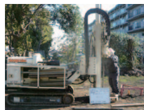
ボーリングの状況
